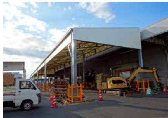
荷揃え場所を確保するため、同社は約2500万円をかけて市場内とトラック駐車場との間に大型の屋根を設置
